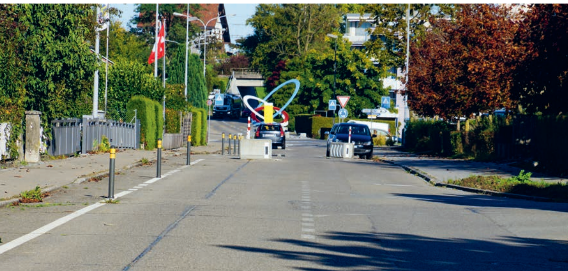
Die Realisierung verschiedener anderer Bauprojekte hat die Sanierung und Umgestaltung der Grünaustrasse verzögert.
