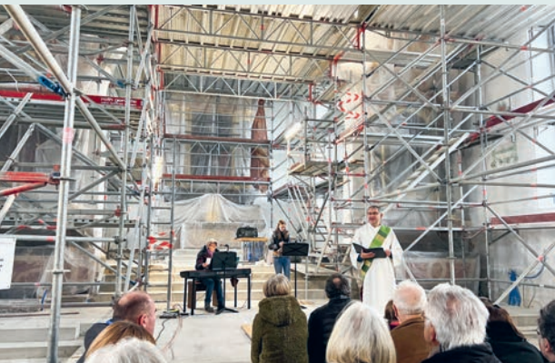
Die Kirche ist eine Baustelle.
