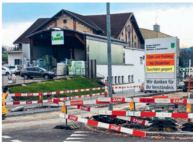
Einschränkungen aufgrund der zweiten Bauetappe an der Romanshorerstrasse.
