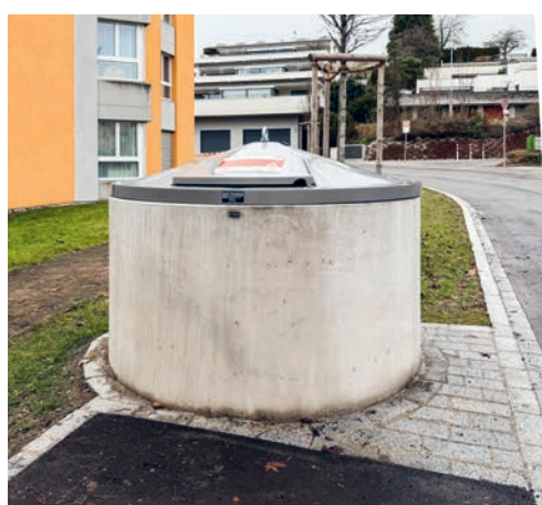
Umsetzung des Strassenprojekts im Sturzbüchel mit Trennsystem, Halbunterflurcontainer und Tempo 30.
