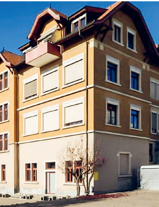
Mit einem vernünftigen Aufwand kann das gelbe Schulhaus wieder reaktiviert werden.
