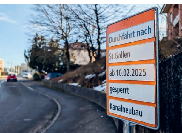
Die Tafel weist darauf hin, dass die Bruggwaldstrasse für die Durchfahrt von und nach St.Gallen gesperrt ist.
